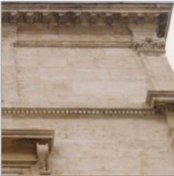
2 - Pierre de taille en calcaire tendre. Le ravalement ne devra pas épauprer les joints.
