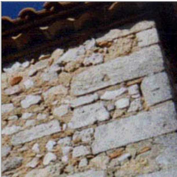
15 - Les murs épais des pignons aveugles restent souvent non enduits par économie.
