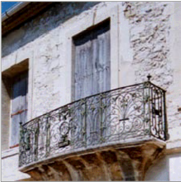
26 - Mal bâties, les petites pierres du mur étaient prévues pour recevoir un enduit.
