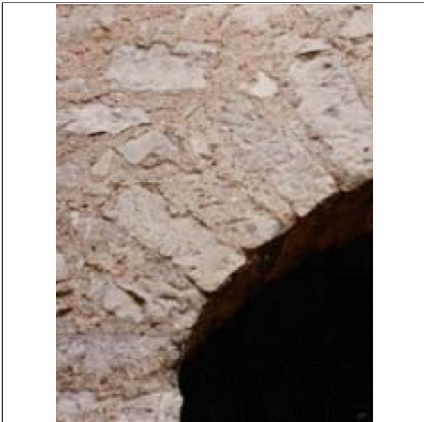
34 - Mortier de chaux et sable terreux. Joints pleins bien réalisés.
