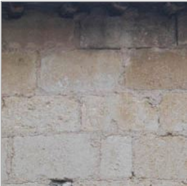
7 - Pierres équarries et joints en terre réalisés en montant le mur.
