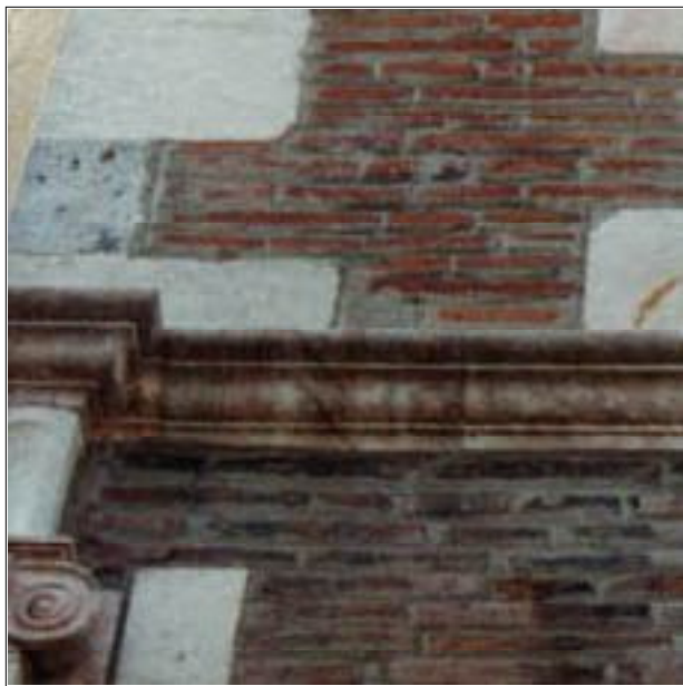
17 - A Perpignan, les briques nommées "caïroux" ont l'épaisseur du mur. Elles sont au nu des encadrements en pierre blanche.
