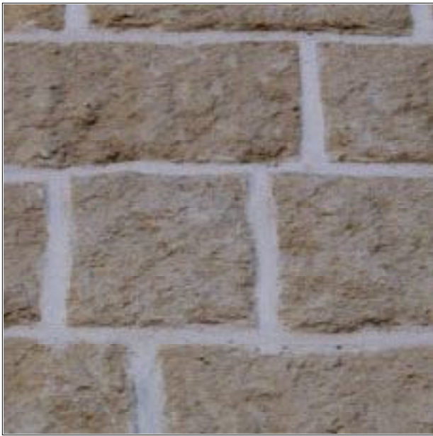
31 - Ces joints trop clairs, trop lisses et hydrofugés détruisent l'effet d'ensemble.
