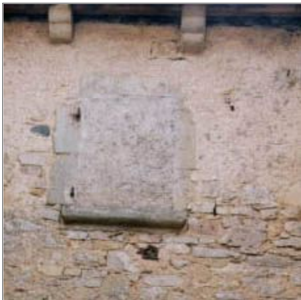
23 - On ne confondra pas les bas de mur dégradés par la pluie et les remontées capillaires, avec les murs à pierres vues. Un enduit recouvrait ces pierres.
