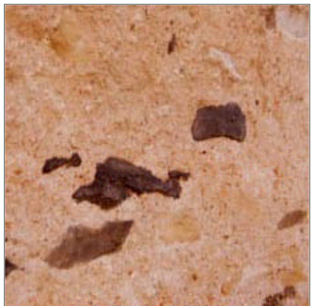
36 - Quand les joints sont bien réalisés ils s'imposent par la qualité de leur matière et laissent aux pierres leur juste place. Elles affleurent sans se détacher une à une.
